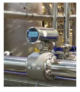
Medición de flujo de agua desionizada/desmineralizada
