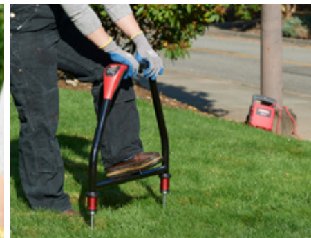
Detección de averías gracias al AF-600 con el transmisor UAT-600
