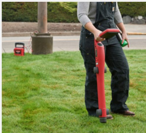
Localice un determinado cable conectando el transmisor directamente con los cables de prueba
